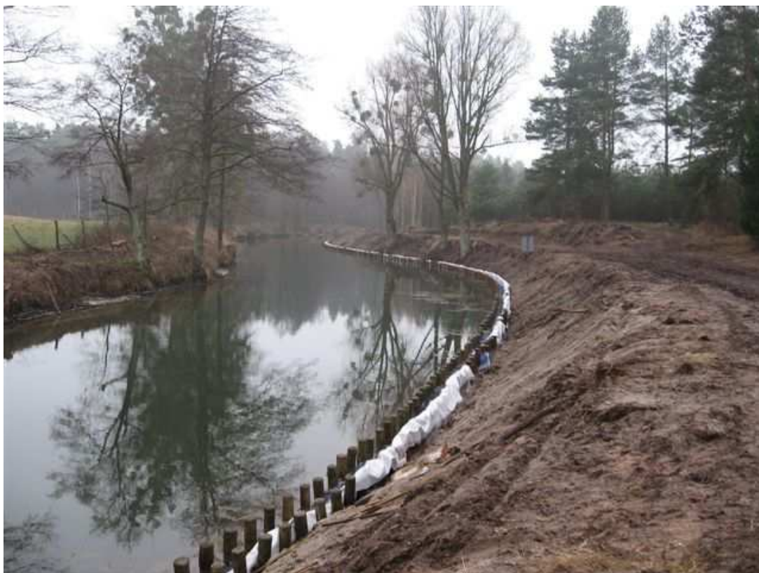
Fot. 4. Umocnienie brzegu na tzw. odcinku ostródzkim.
