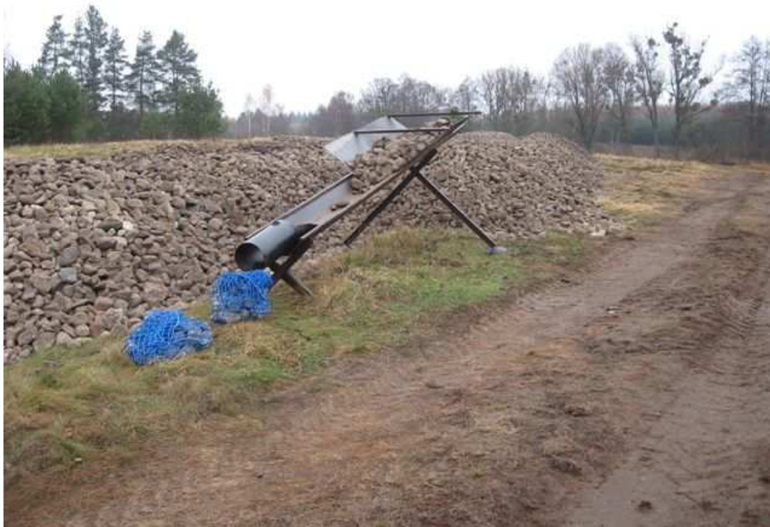
Fot. 2. Przygotowanie walców kamiennych – elementów umocnień brzegowych.
