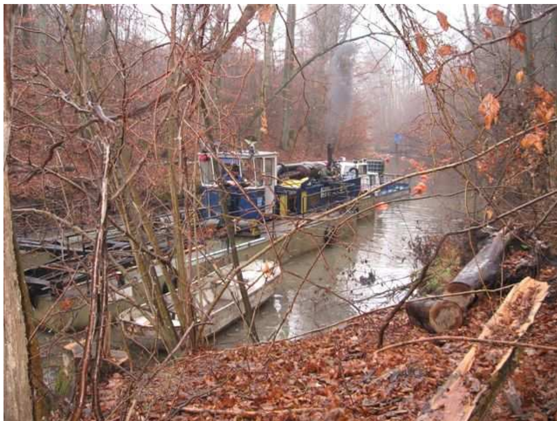
Fot. 8. Pracująca pogłębiarka na Kanale Bartnickim.
