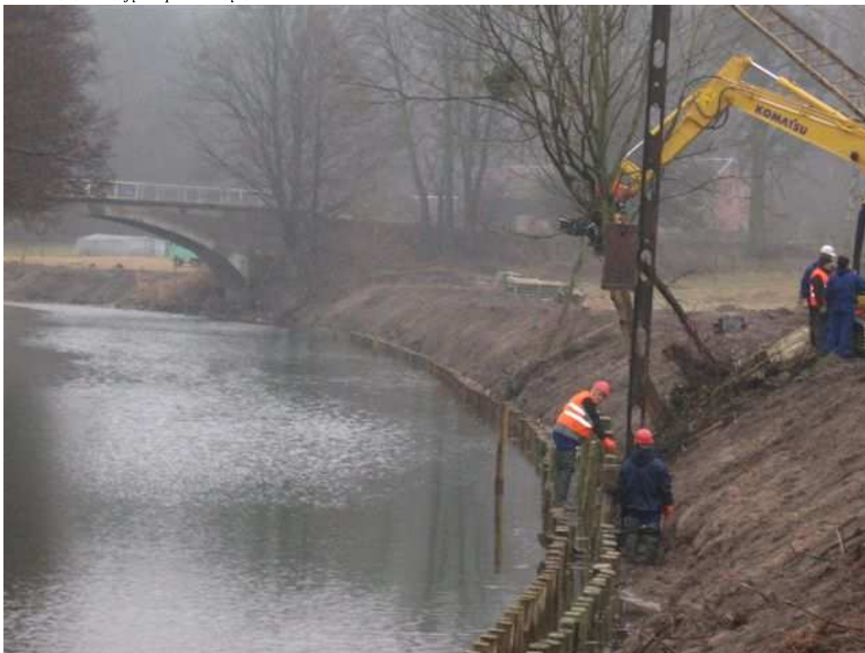
Fot. 1. Wbijanie pali podwójnej palisady drewnianej na tzw. odcinku ostródzkim (umocnienie brzegowe).
