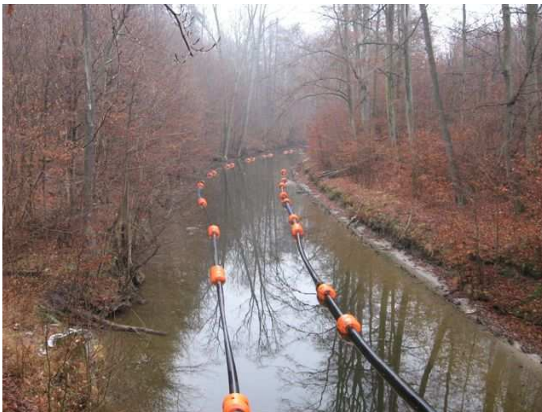
Fot. 7. Rurociąg ssąco – tłoczący do transportu refulatu rozciągnięty w korycie Kanału Bartnickiego.
