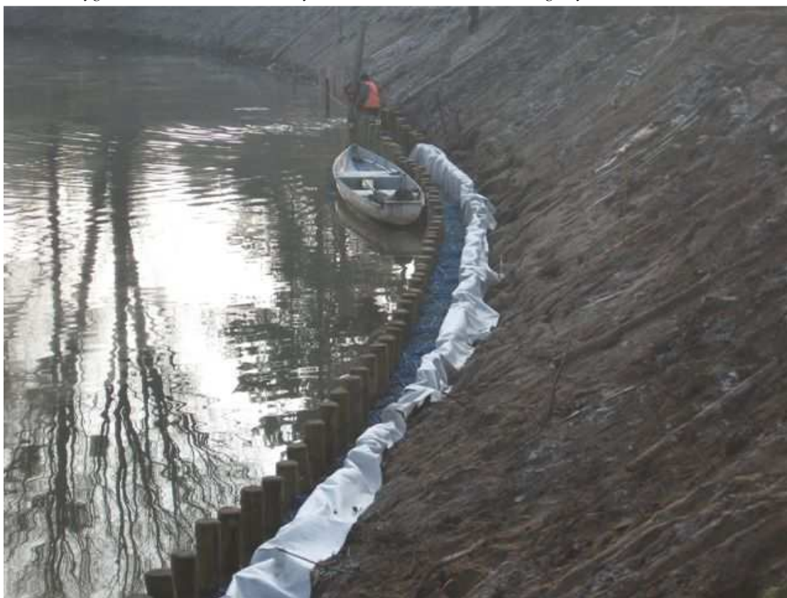
Fot. 3. Układanie walców kamiennych pomiędzy palami tworzącymi podwójną palisadę (umocnienie brzegowe).
