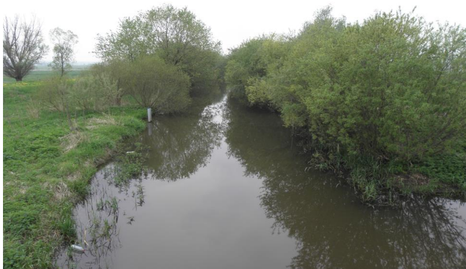
Rzeka Dzierzgoń przed rozpoczęciem robót budowlanych powyżej mostu w m. Bągart.
