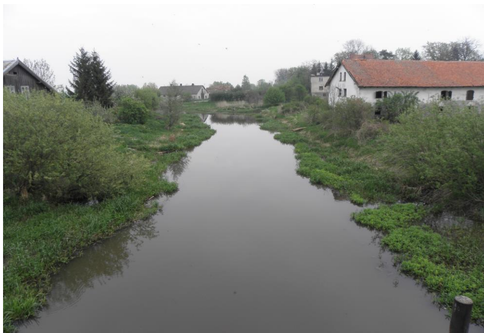
Rzeka Dzierzgoń przed rozpoczęciem robót budowlanych poniżej mostu w m. Stare Dolno.
