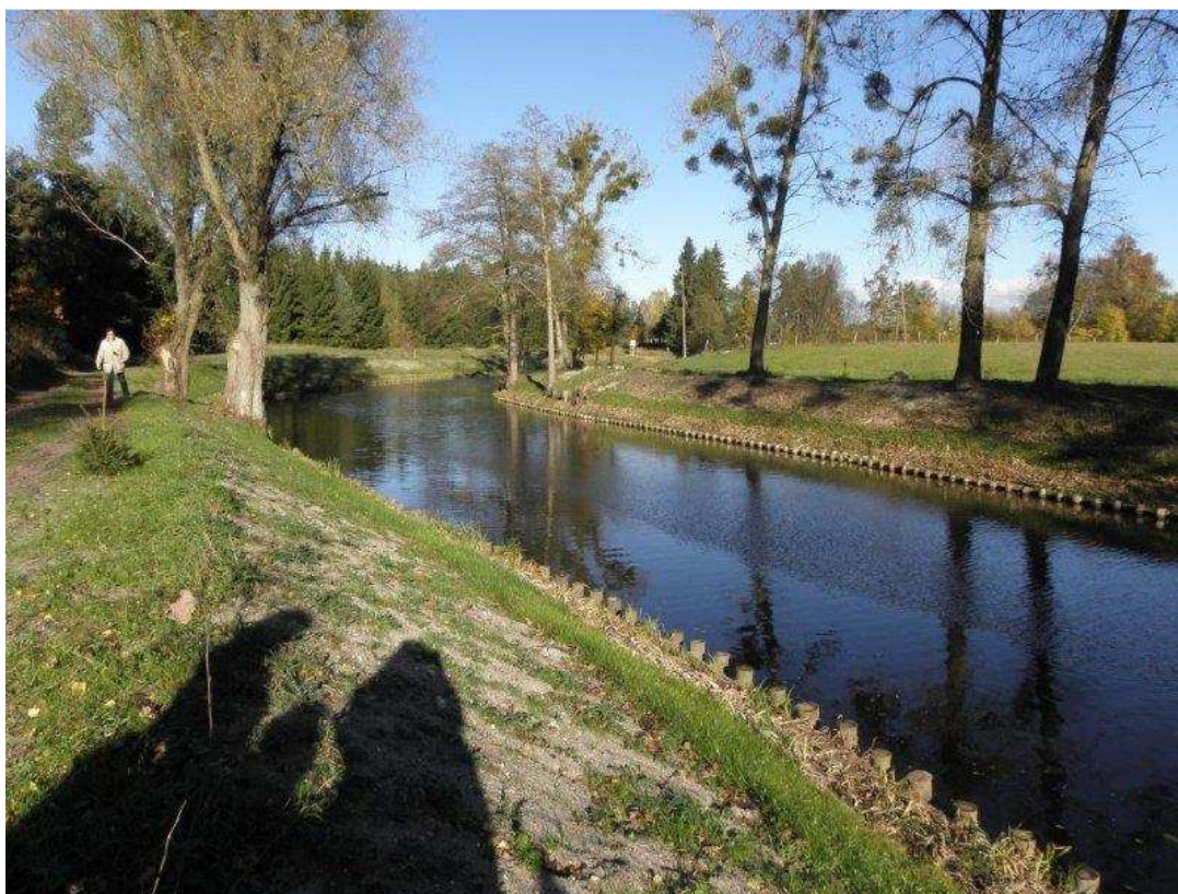
Fot. 3. Podwójna palisada drewniana na tzw. odcinku ostródzkim (umocnienie brzegowe).
