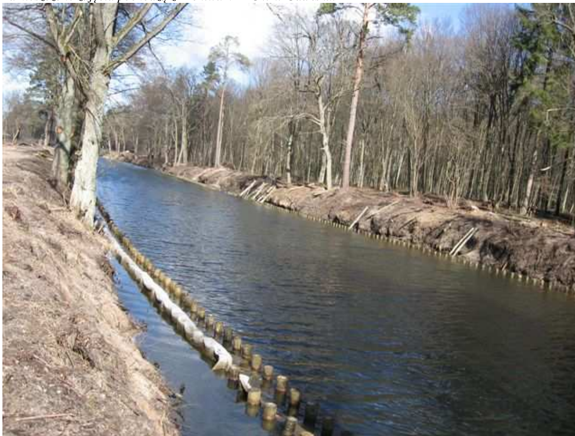
Fot. 1. Umocnienia brzegowe obu brzegów na tzw. odcinku ostródzkim.
