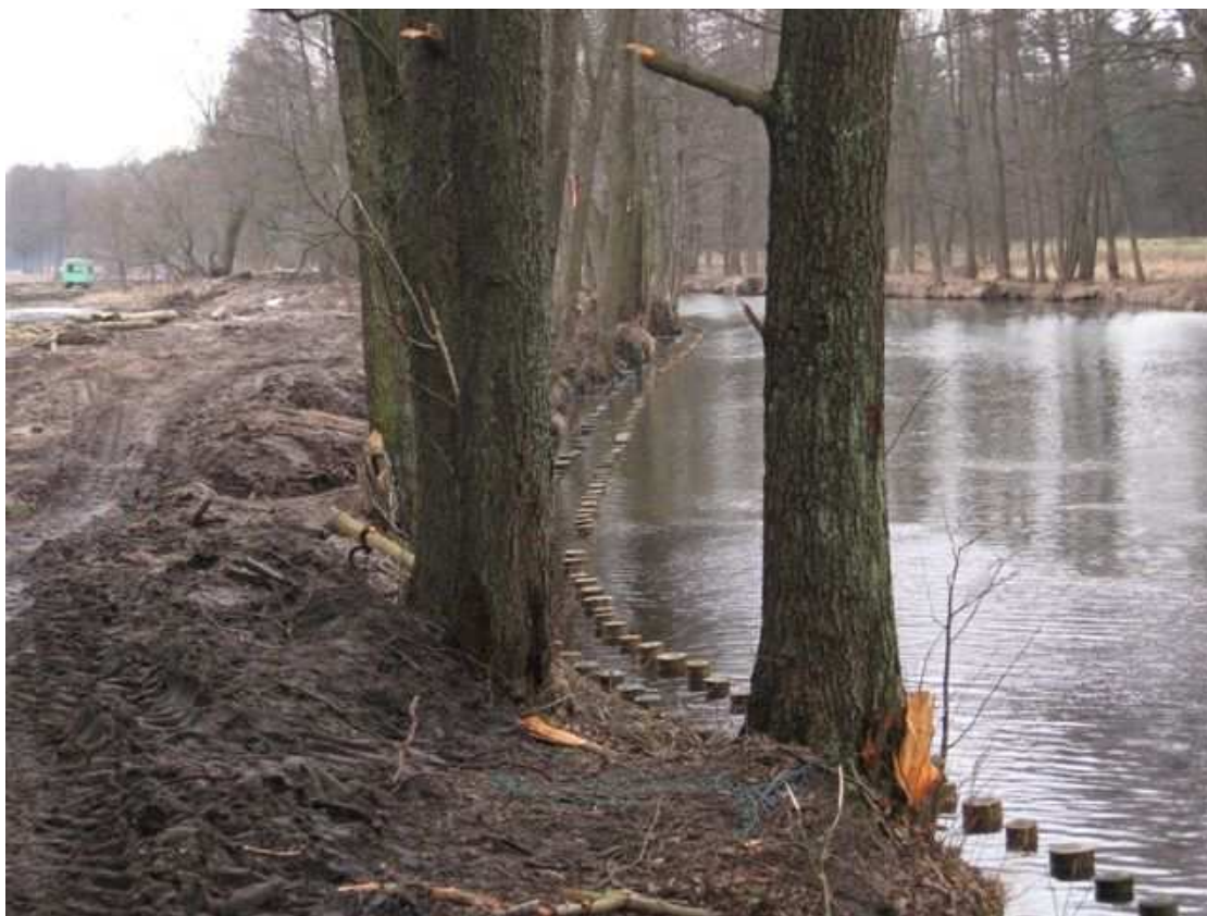
Fot. 2. Umocnienia brzegowe na tzw. odcinku ostródzkim.
