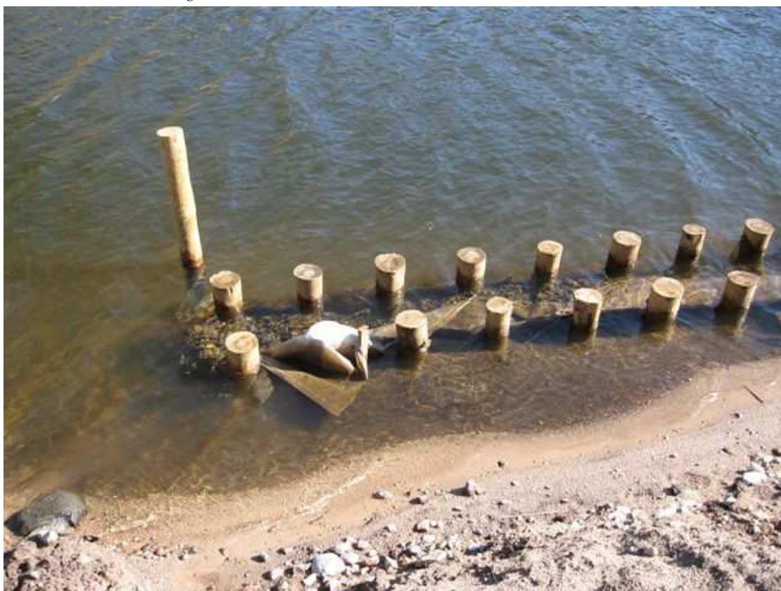
Fot. 3. Podwójna palisada drewniana z walcem kamiennym na tzw. odcinku ostródzkim.
