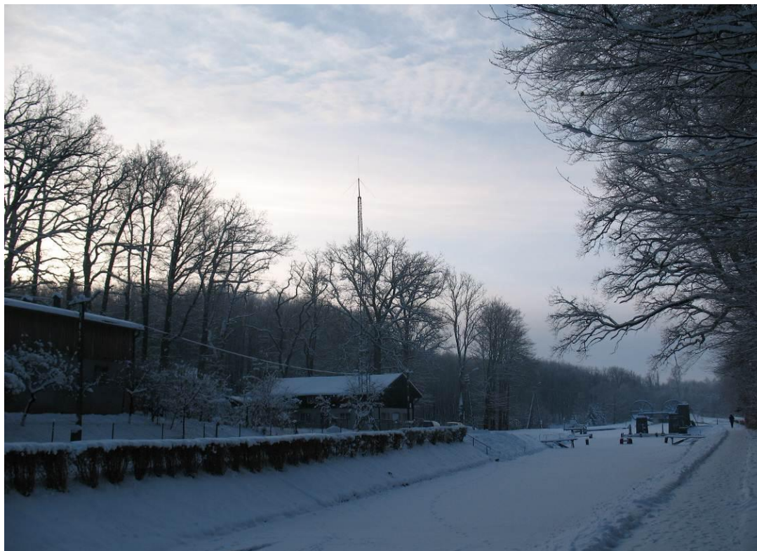
Fot.4. Widok na stanowisko górne na pochylni Buczyniec. Własność: Nadzór inwestorski projektu
