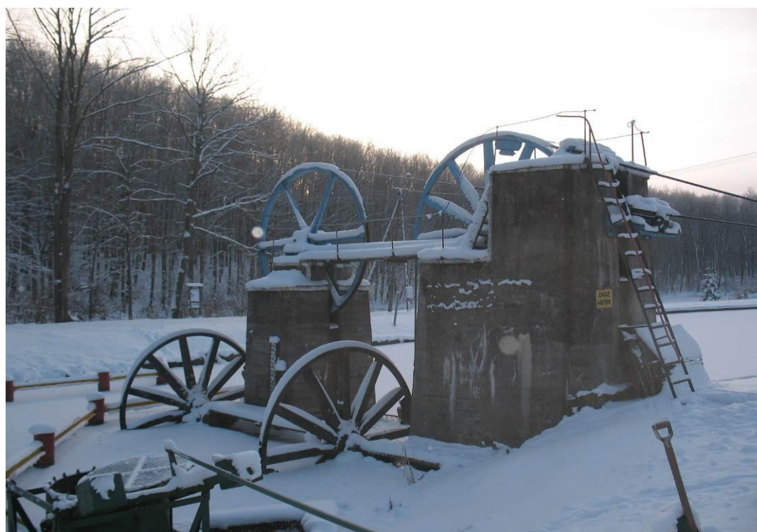
Fot.5. Widok na filary kół linowych na stanowisku górnym pochylni Buczyniec.. Własność: Nadzór inwestorski projektu
