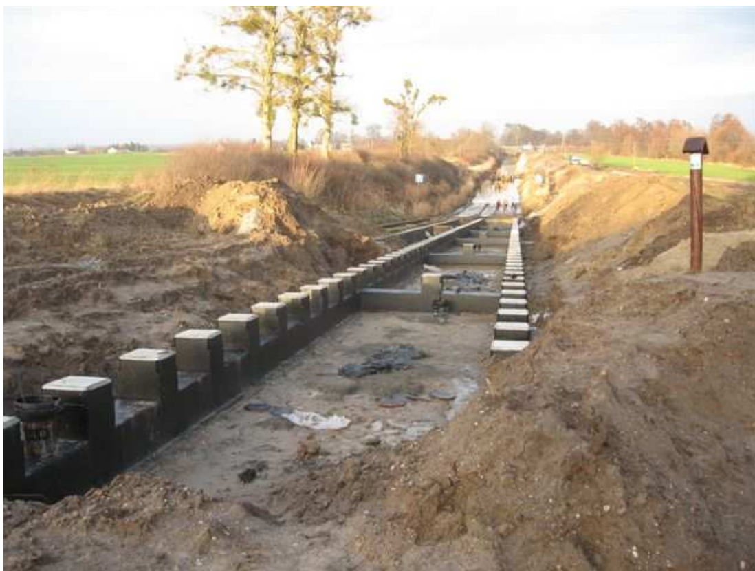
Fot. 7. Pochylnia Jelenie – stanowisko górne (w kierunku stanowiska dolnego).
