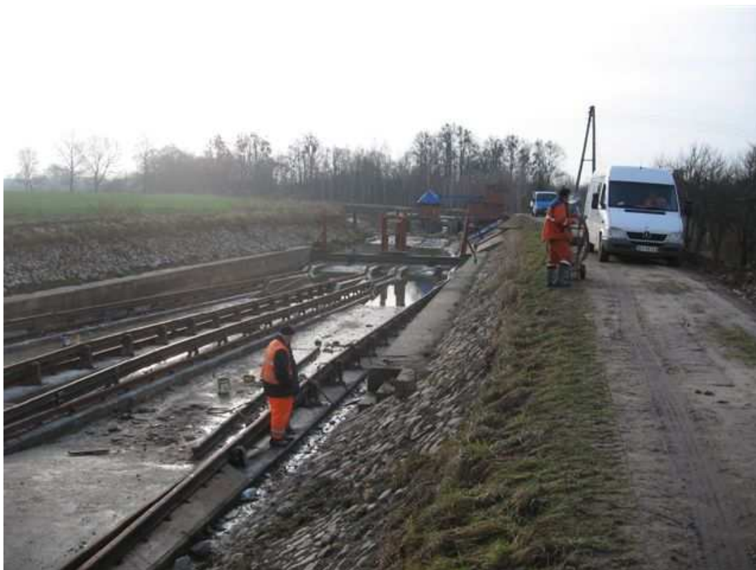
Fot. 10. Pochylnia Oleśnica – stanowisko górne.
