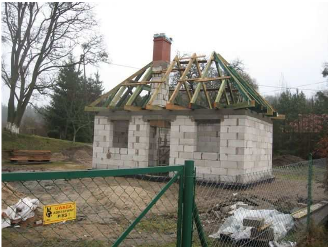
Fot. 18. Śluza Zielona – budynek operatora śluzy.
