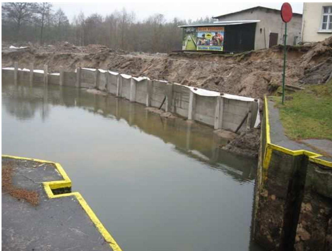
Fot. 17. Śluza Zielona – budowa umocnień brzegowych na stanowisku górnym.
