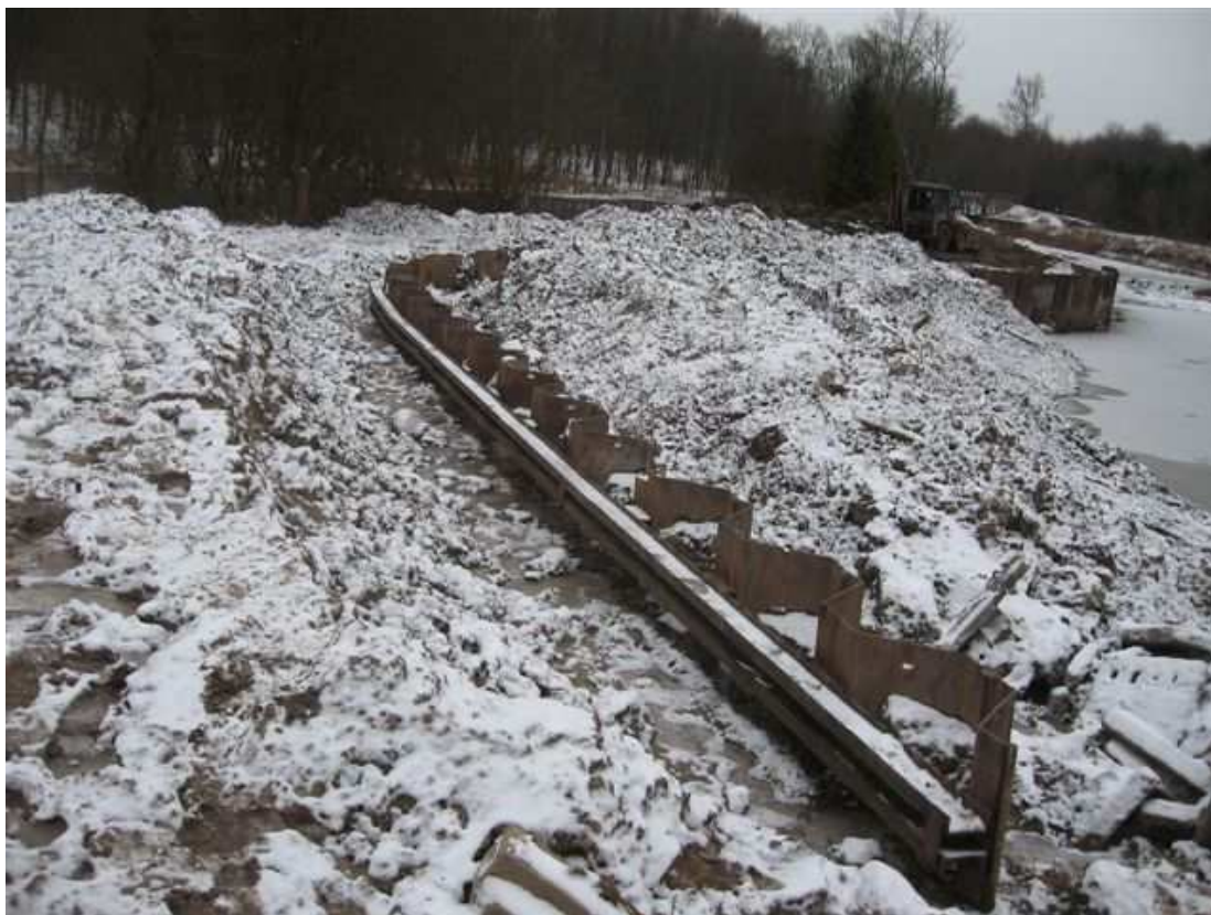
Fot. 4. Pochylnia Buczyńiec – stanowisko górne (budowa obrotnicy dla statków).
