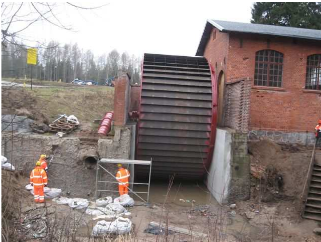
Fot. 14. Pochylnia Kąty – budynek maszynowni.
