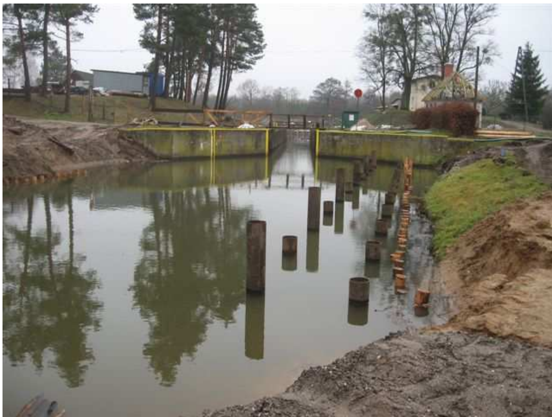
Fot. 16. Śluza Zielona – budowa umocnień brzegowych na stanowisku dolnym.
