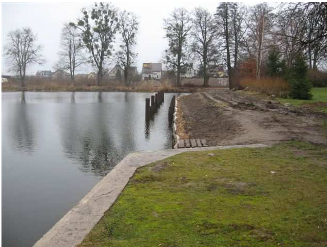
Fot. 19. Śluza Miłomłyn – stanowisko górne, brzeg lewy.
