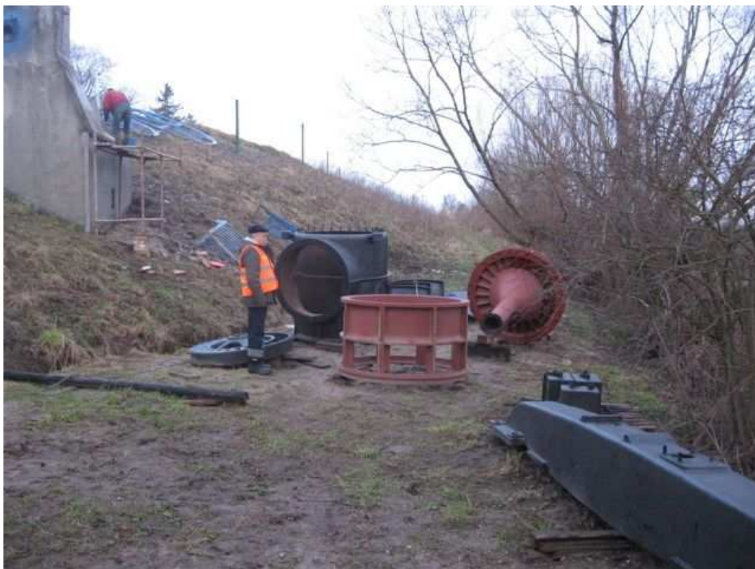
Fot. 5. Pochylnia Całuny – zdemontowane urządzenia maszynowni.
