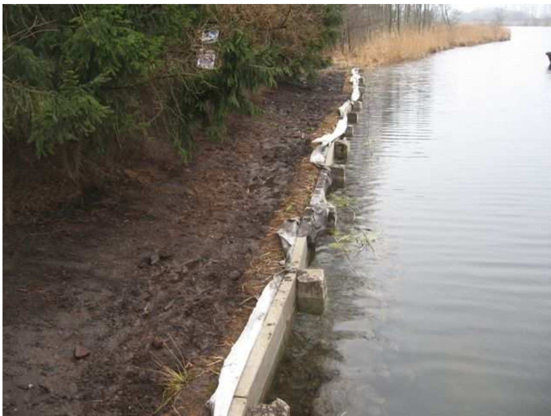
Fot. 21. Śluza Miłomłyn – budowa umocnień brzegowych na stanowisku dolnym.
