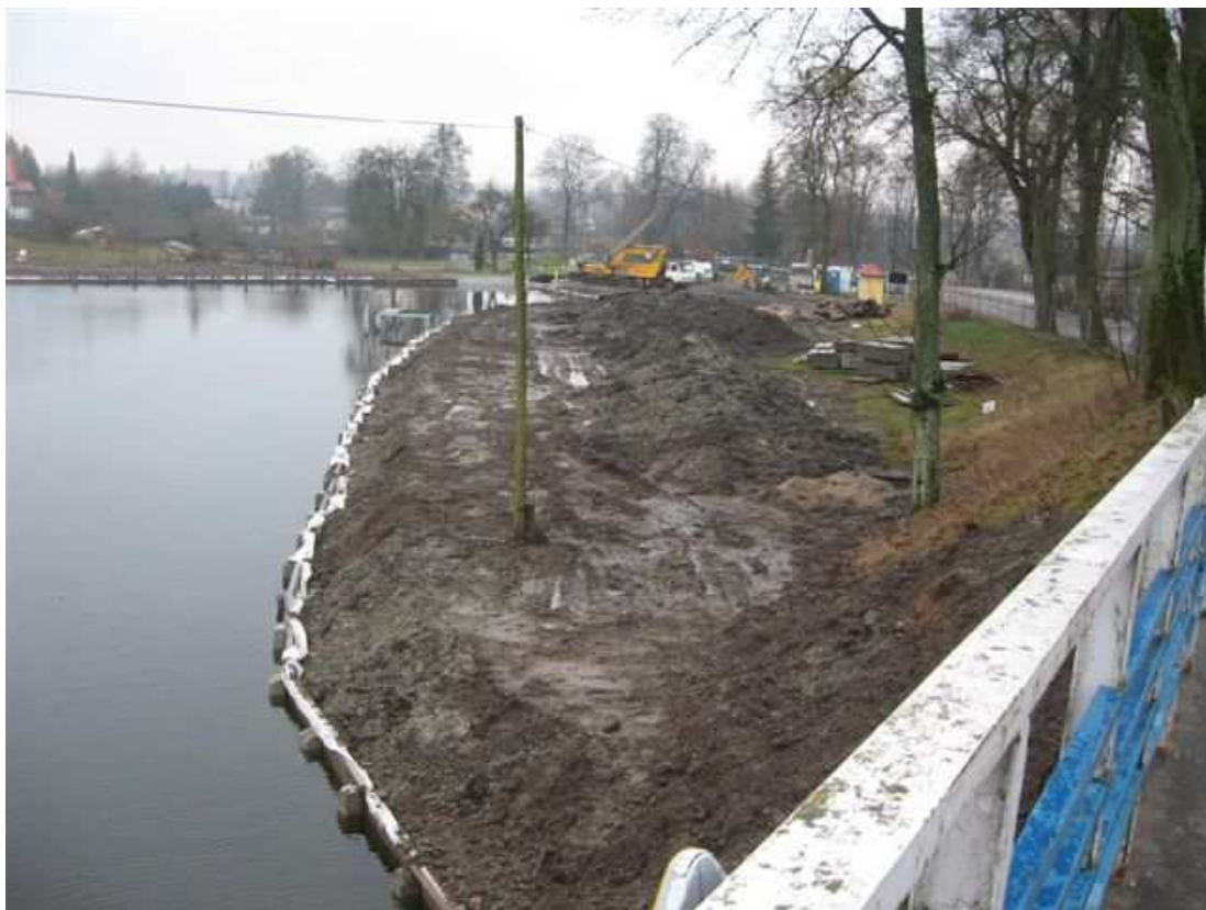
Fot. 20. Śluza Miłomłyn – stanowisko górne, brzeg prawy (widok z mostu).
