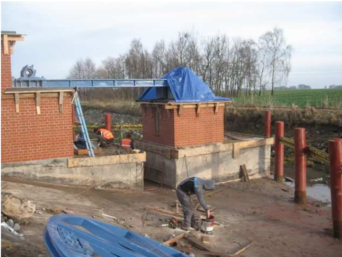
Fot. 11. Pochylnia Oleśnica – filar kół linowych na stanowisku górnym.
