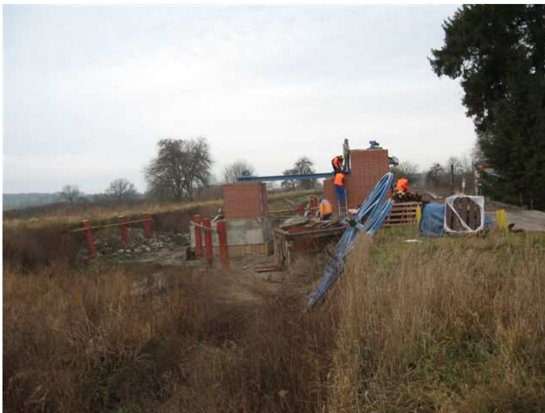
Fot. 15. Pochylnia Kąty – filar kół linowych na stanowisku górnym.
