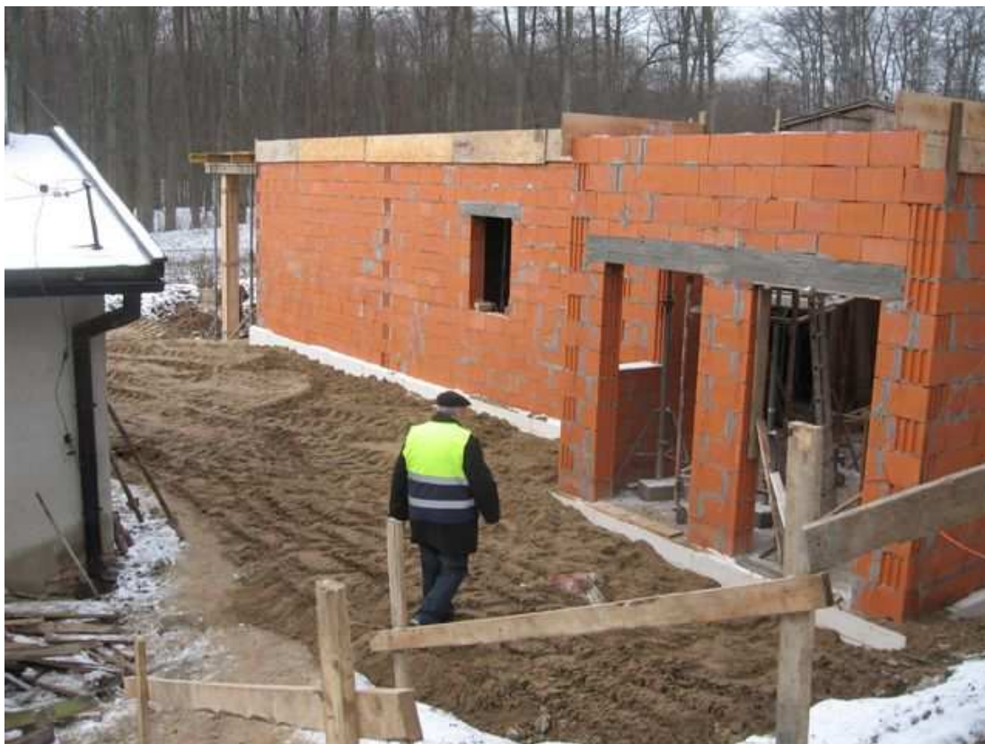
Fot. 2. Pochylnia Buczyńiec – budowa budynku Izby Historii Kanału Elbląskiego.
