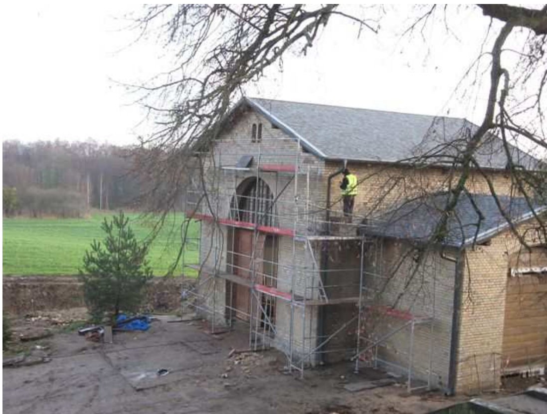
Fot. 9. Pochylnia Jelenie – budynek maszynowni.
