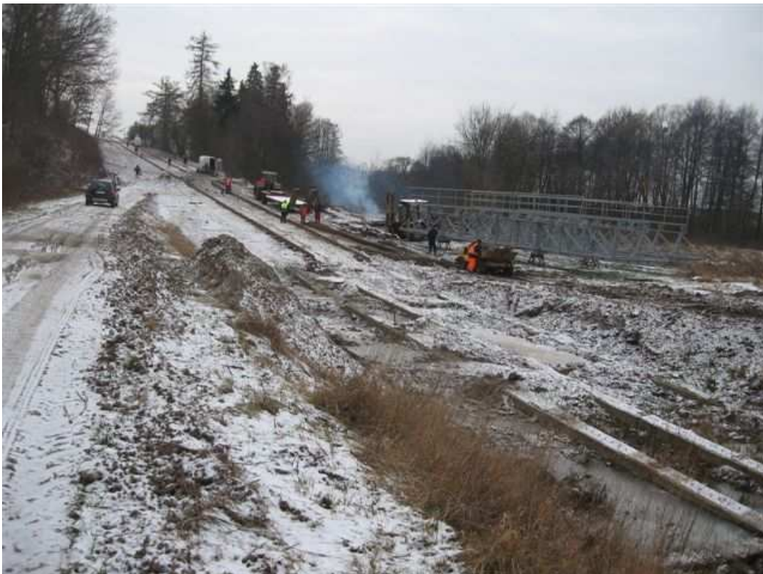
Fot. 12. Pochylnia Oleśnica – stanowisko dolne.
