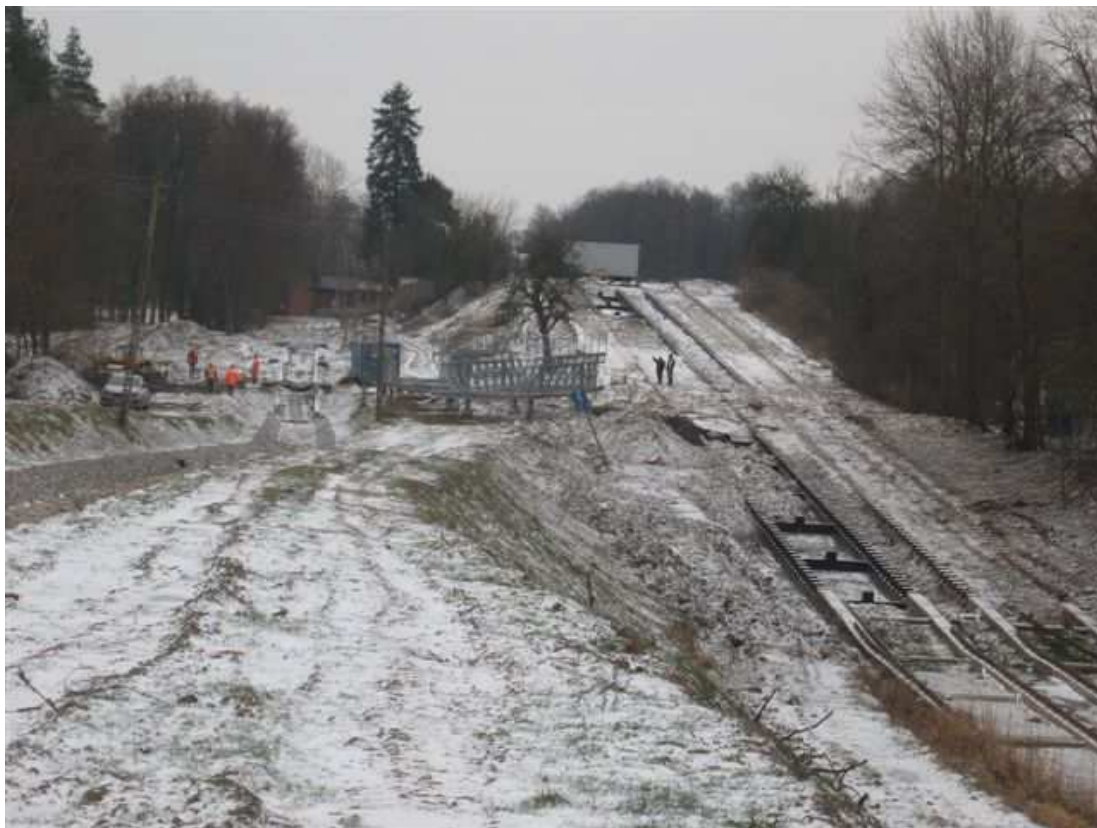
Fot. 13. Pochylnia Kąty – stanowisko dolne (w kierunku stanowiska górnego).
