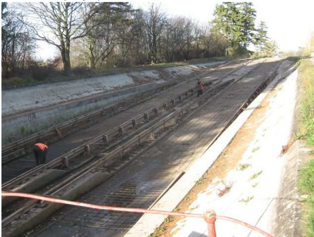
Fot. 11. Stanowisko górne pochylni Jelenie.
