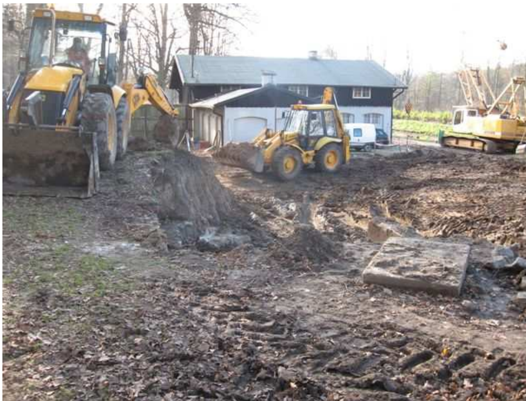
Fot. 1. Wykop pod fundamenty Izby Historii Kanału (w tle widoczny budynek Nadzoru Wodnego Buczyńiec).
