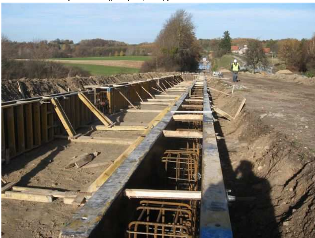
Fot. 5. Budowa fundamentów pod torowiska na pochylni Kąty.
