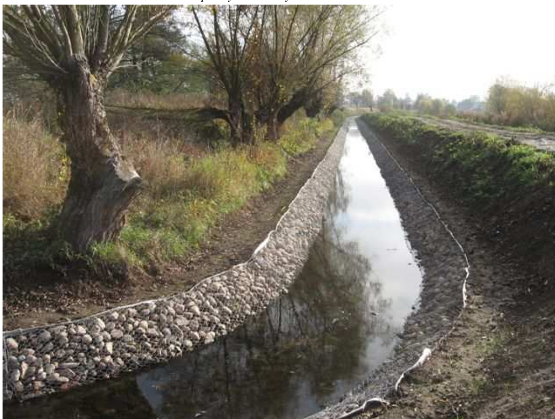
Fot. 15. Kanał obiegowy na pochylni Całuny.
