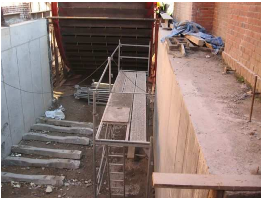
Fot. 4. Remont komory koła wodnego na pochylni Kąty.
