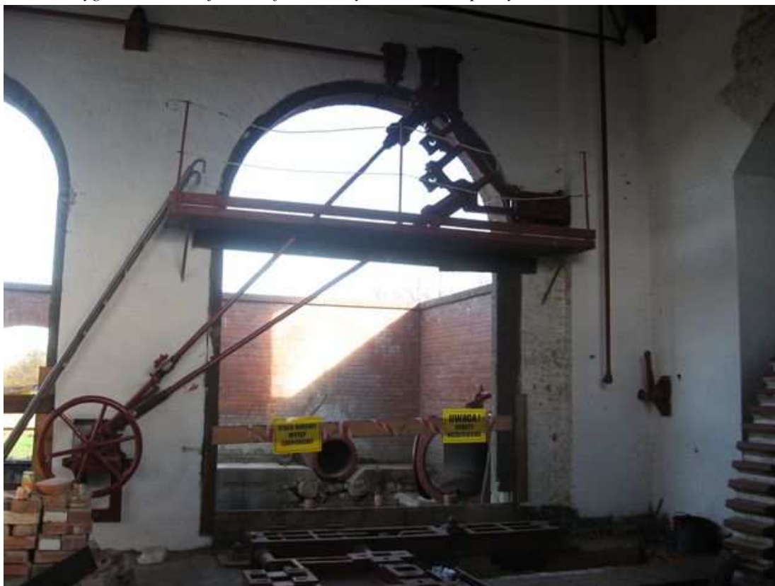
Fot. 9. Remont w budynku maszynowi na pochylni Oleśnica.
