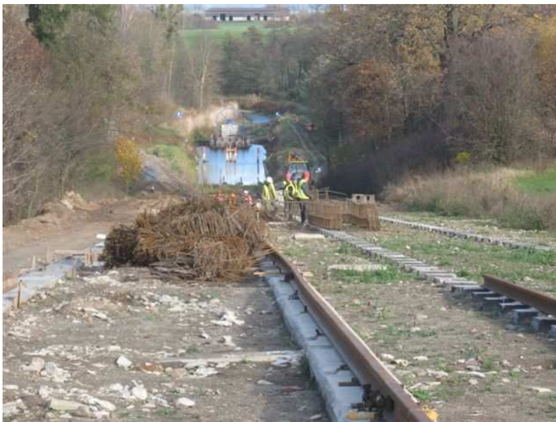
Fot. 8. Przygotowanie zbrojenia na fundamenty torowiska na pochylni Oleśnica.
