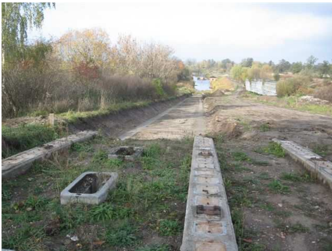
Fot. 14. Widok na stanowisko dolne pochylni Całuny.
