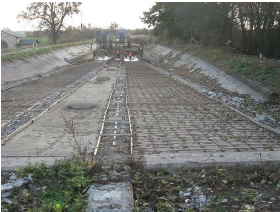
Fot. 10. Stanowisko górne pochylni Jelenie.
