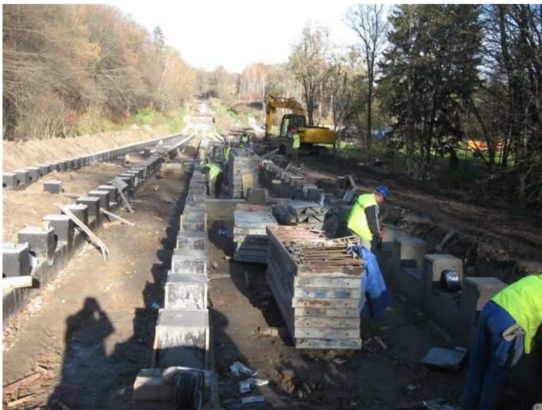
Fot. 2. Budowa fundamentów pod torowiska na pochylni Buczyniec.
