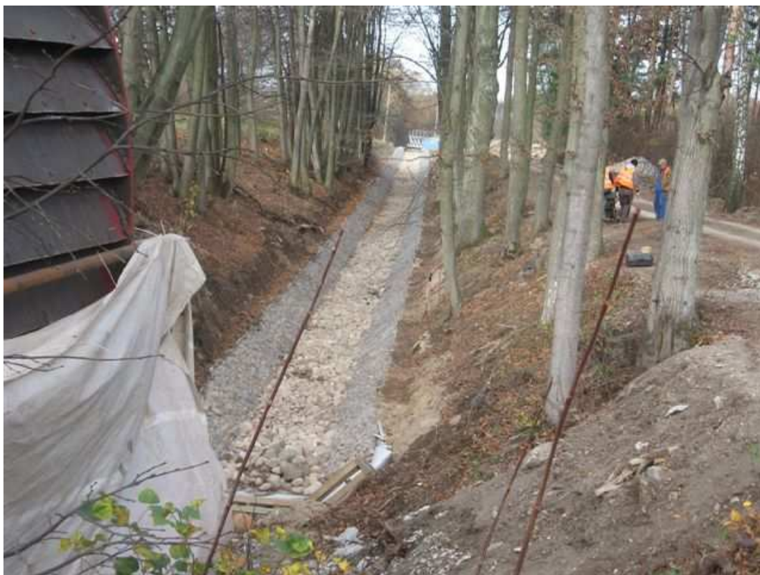
Fot. 6. Kanał obiegowy na pochylni Kąty.
