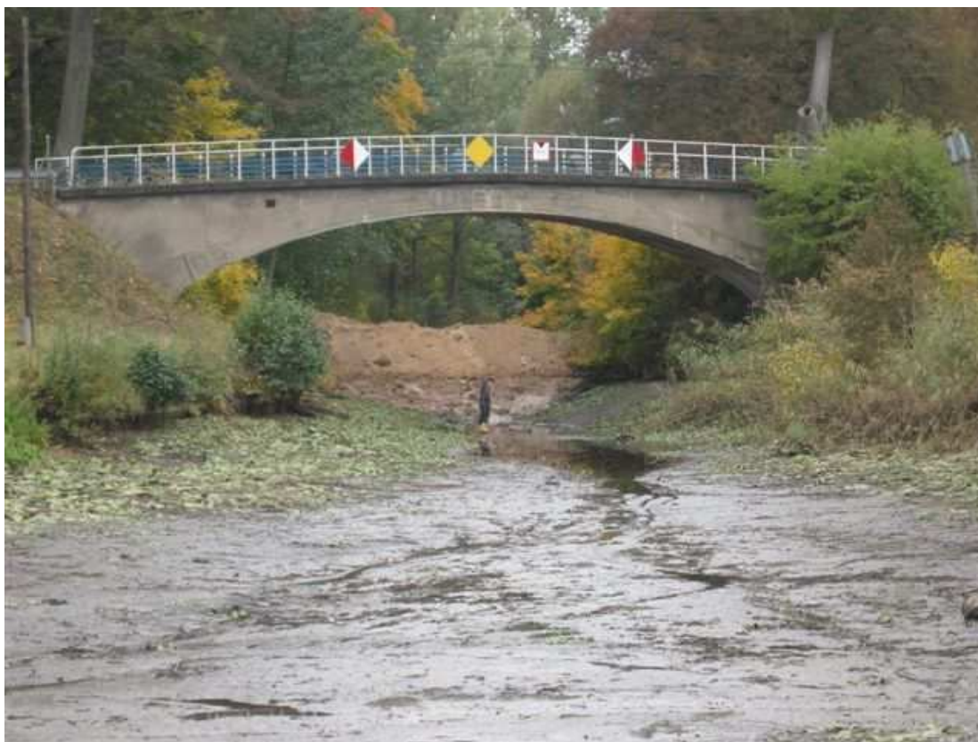
Fot. 9. Odwodniony fragment szlaku za służą Miłomłyn w kierunku Hławy (za mostem widoczna grodza ziemna).
