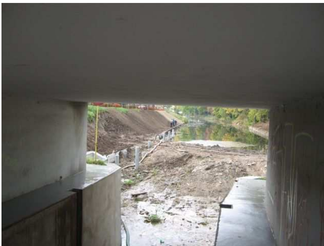
Fot. 4. Śluźca Ostróda – budowa umocnień brzegowych na stanowisku dolnym.
