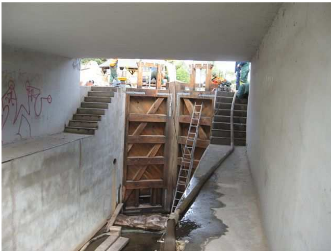
Fot. 3. Wymienione wrota dolne na śluźce Ostróda.
