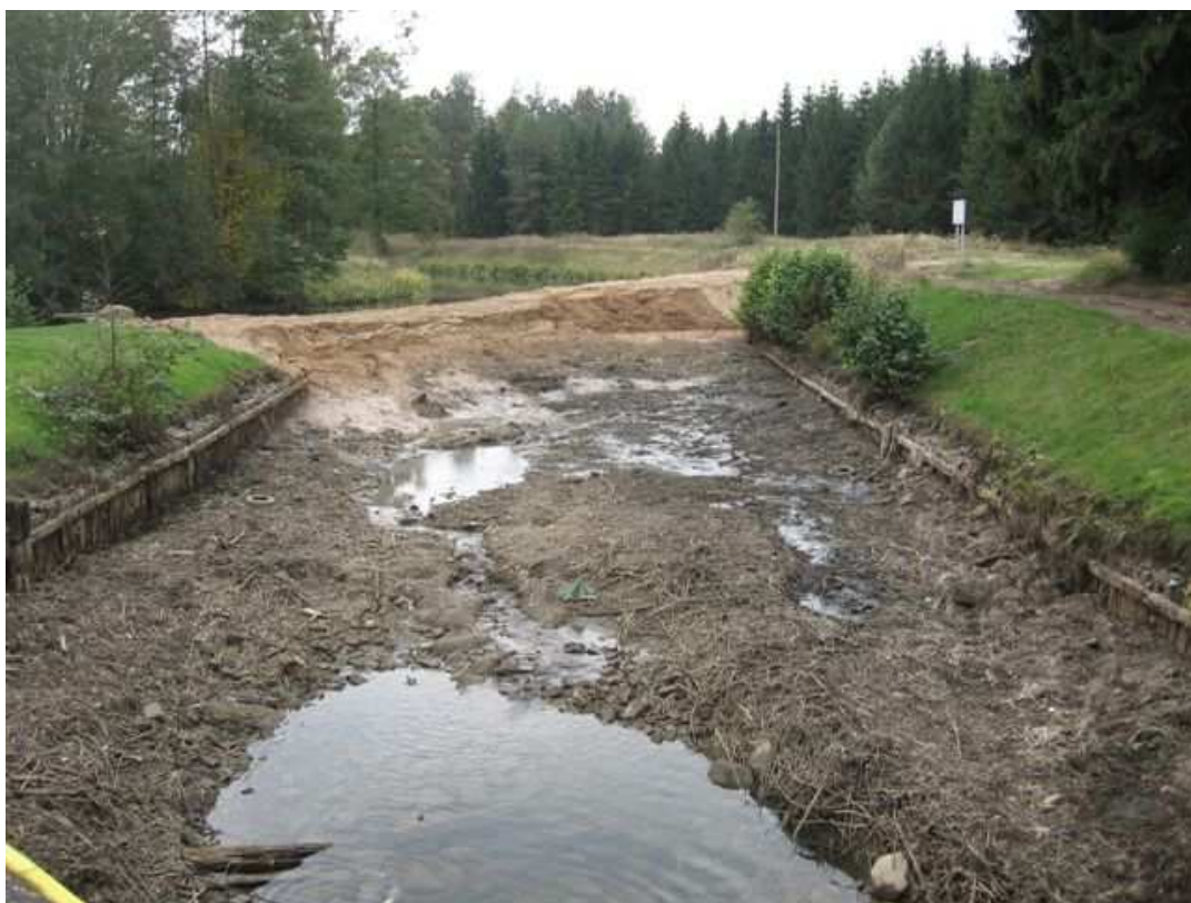
Fot. 12. Śluza Zielona – odwodnione stanowisko dolne (w tle widoczna grodzia ziemna). Zamieszczone zdjęcia stanowią własność Archiwum RZGW Gdańsk.
