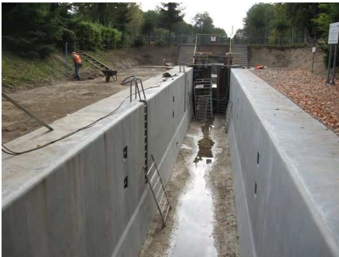
Fot. 5. Śluza Mała Ruś – wnętrze komory śluzy (widok na głowę dolną).
