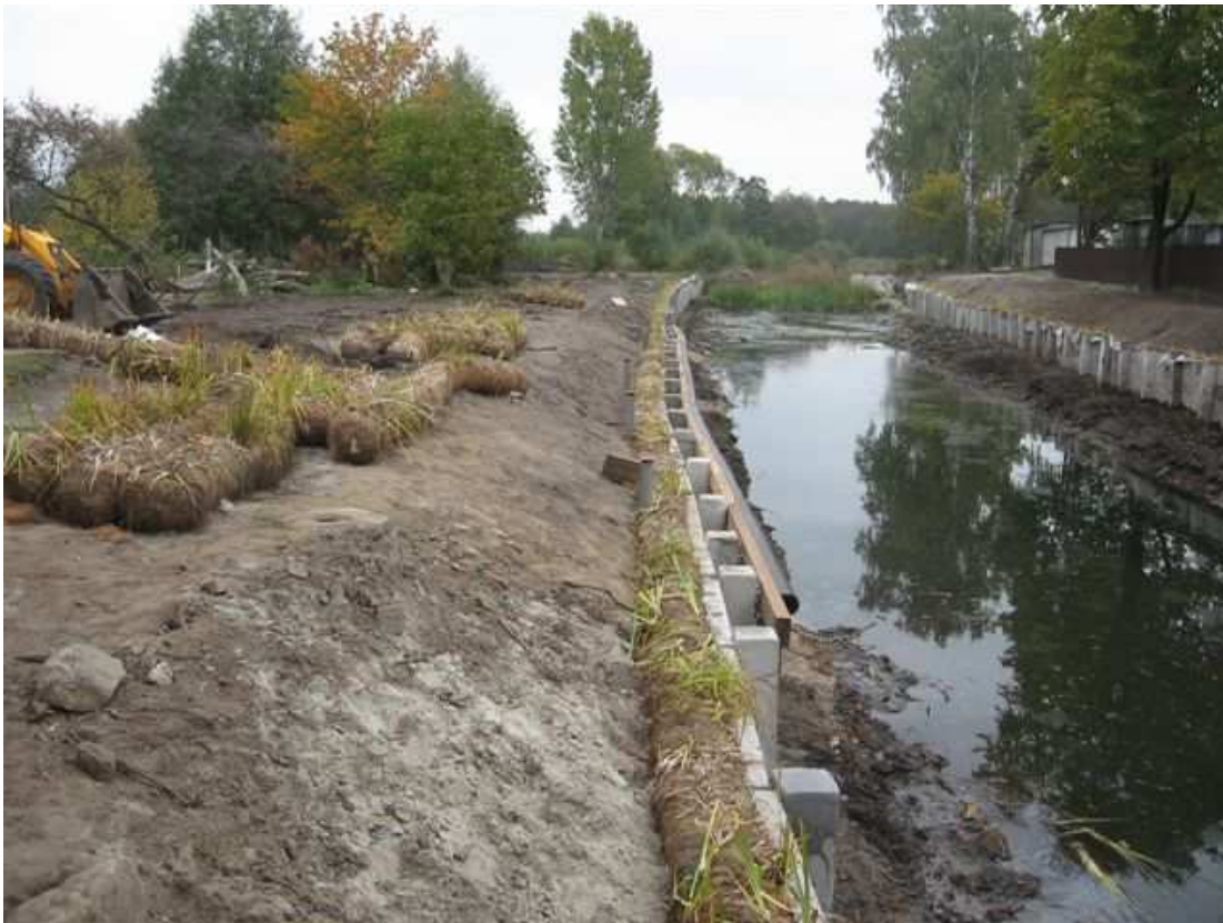
Fot. 1. Śluza Ostróda – budowa umocnień brzegowych na stanowisku górnym.
