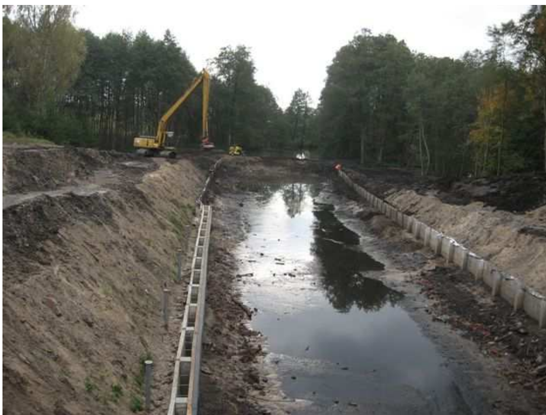
Fot. 6. Śluza Mała Ruś – budowa umocnień brzegowych na stanowisku dolnym.
