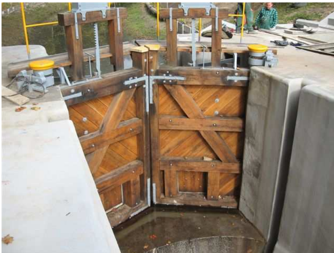
Fot. 7. Wymienione wrota górne na śluzie Mała Ruś.
