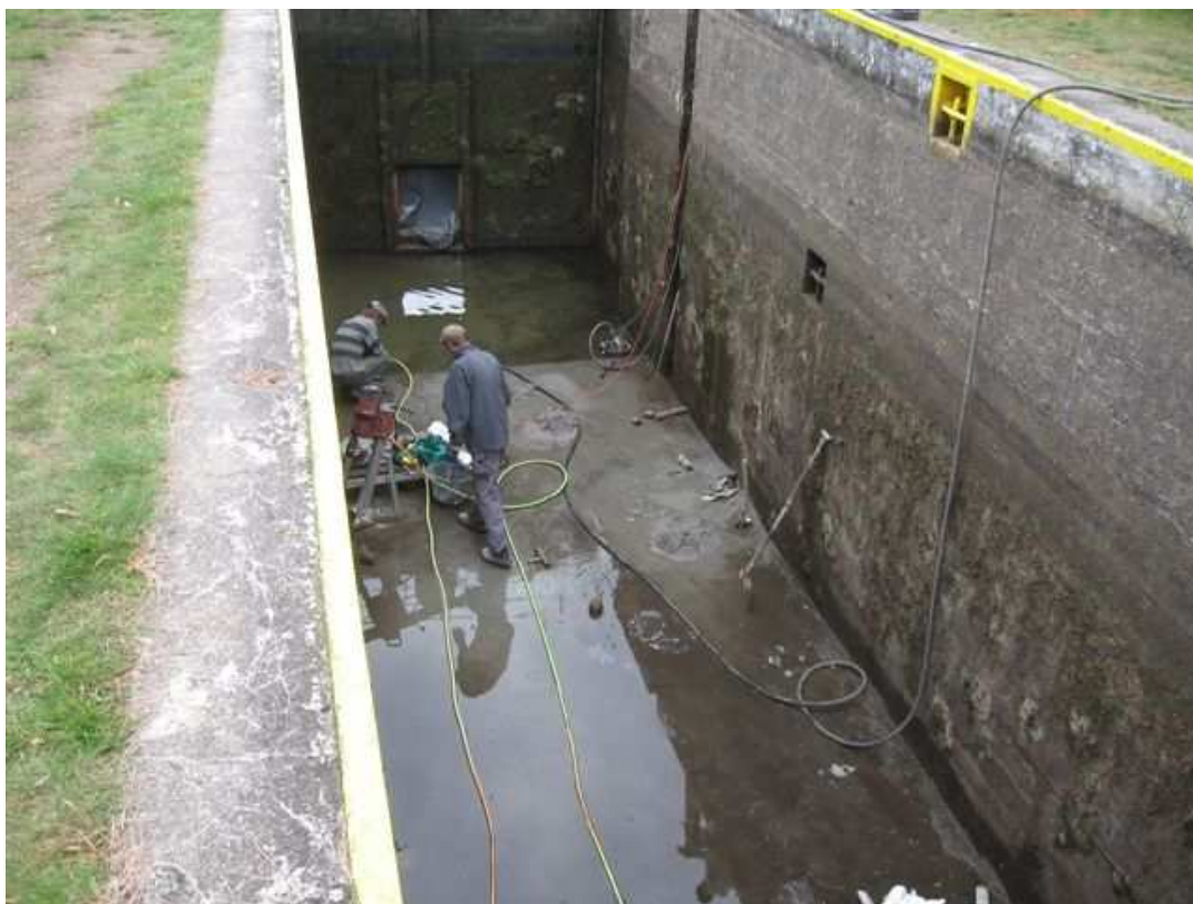
Fot. 11. Śluza Zielona – odwodnione wnętrze komory śluzy.
