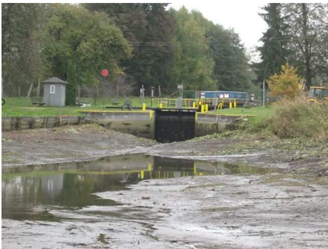
Fot. 8. Śluza Miłomłyn – odwodnione stanowisko górne.
